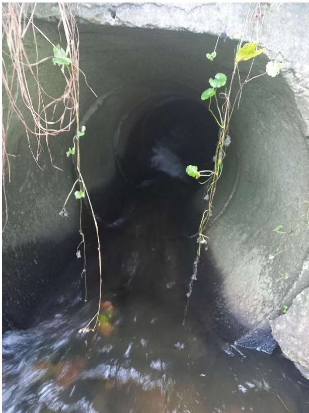
Figur 3: Indløb rør st. 2.046 m, hvor det kraftige fald danner en spærring for optrækkende fisk.
